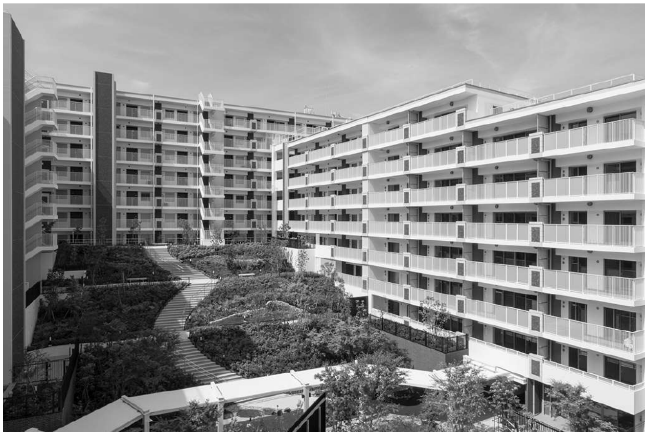
六興電気の仕事の軸はマンション工事（横浜市東戸塚）
